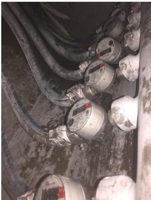
Abb. 2: Durchfluss-Messgeräte eingebaut in einen Filterturm
