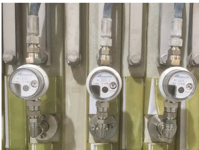
Einzelnachpressanschluss (Serie 1)
